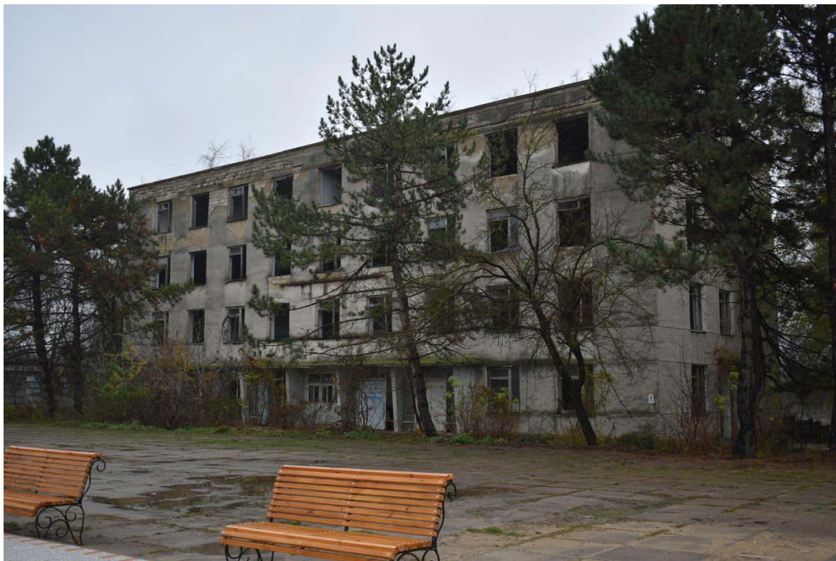
Figura nr. 3.10. Clădire degradată și abandonată (cartierul Sud)
