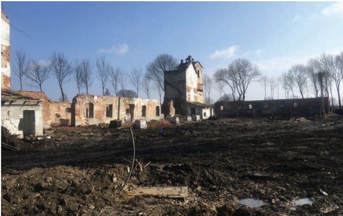
Zona înainte de revitalizare
